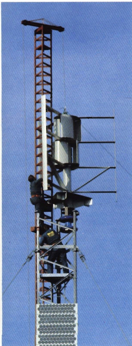
Fig. 16 Montering av vindturbin
