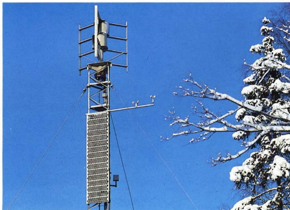
Fig. 1 ERICSSON SUNWIND. Under vindgeneratören är solcellpaneler monterade
